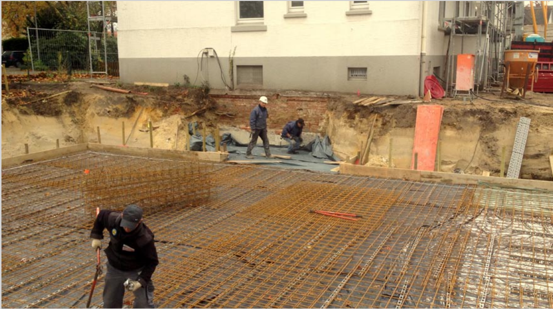
Stahlbetonfundament des Neubaus
