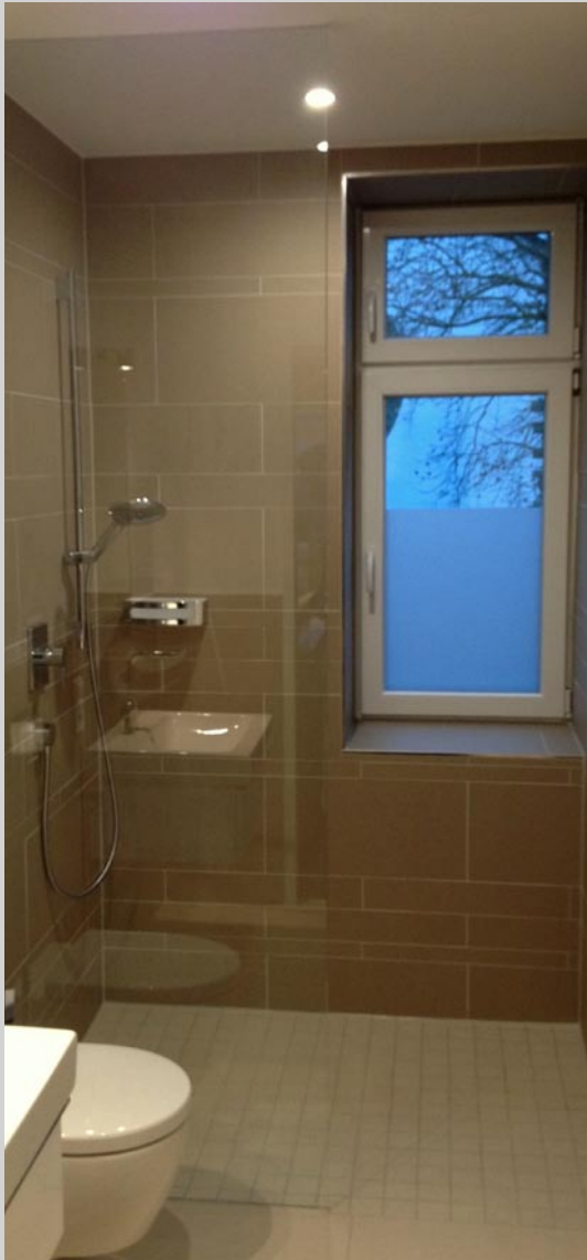
Badezimmer mit ebenerdiger Dusche
