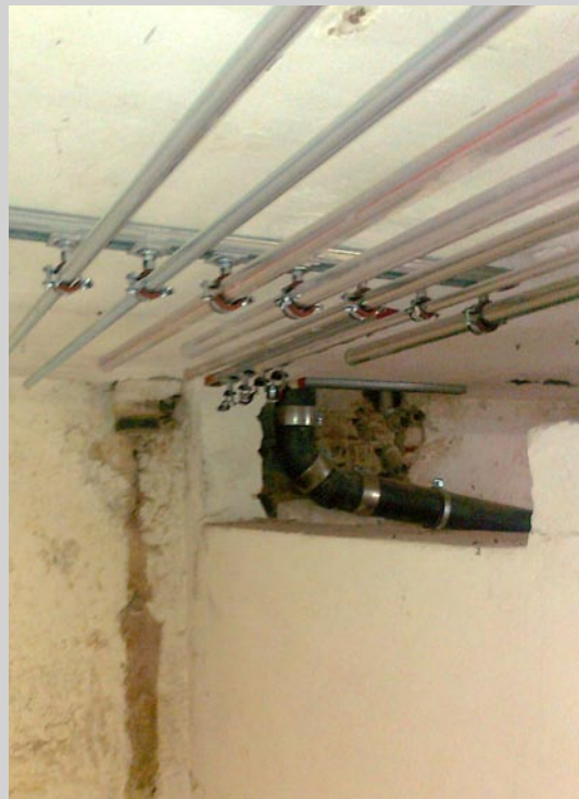
Neue Hauptversorgungsstrasse im Untergeschloss (Heizung/Sanitär)
