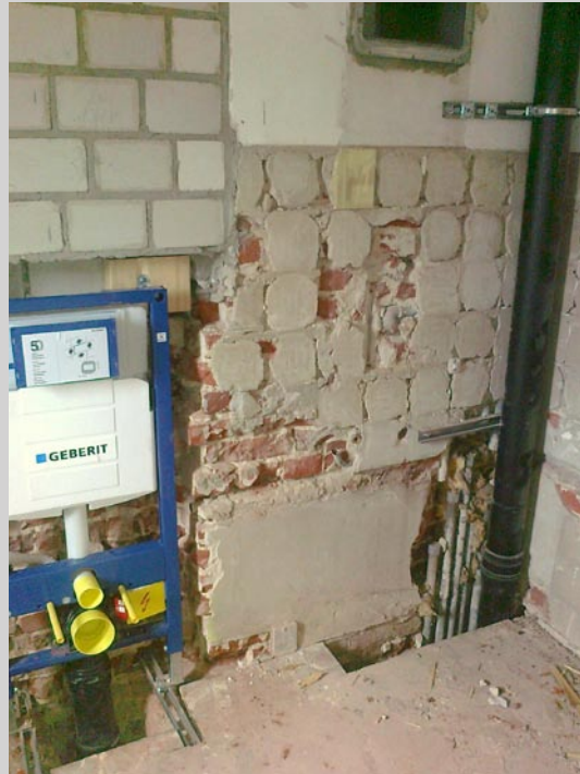
Neuinstallation der Sanitärbereiche einschl. neuer Ver- und Entsorgungsleitungen
