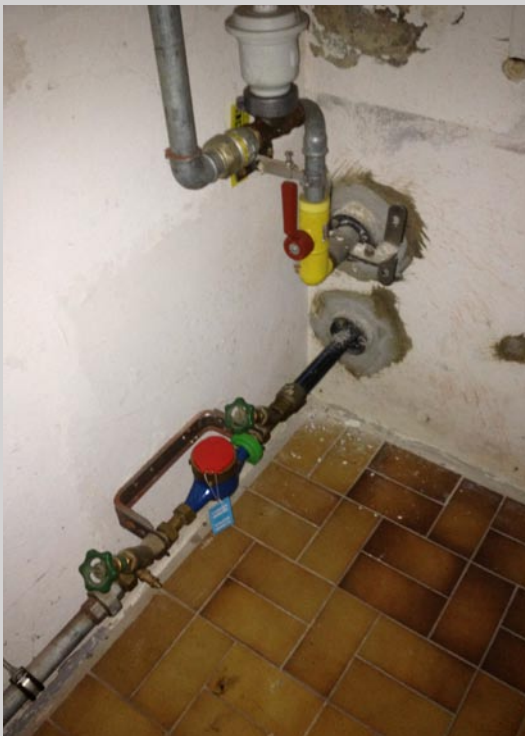
Hausanschluss Bestand für Erdgas und Trinkwasser. Weiterhin genutzt.
