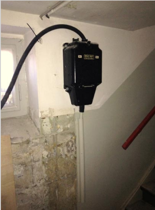
Alter Elektro-Hausanschlusskasten im Treppenhaus. Während der Bauphase als Anschlussverteiler für den Baustrom genutzt.
