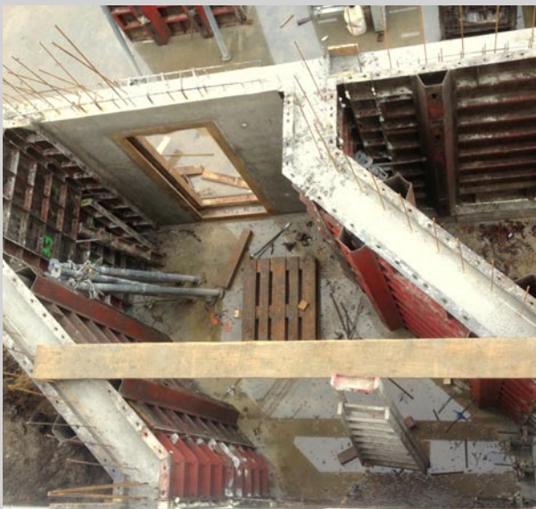
Verbindung der Gebäude/ Rohbau
